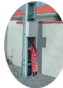
Réseau aérien : Coffret sur poteau (Cas du terrain non viabilisé)
